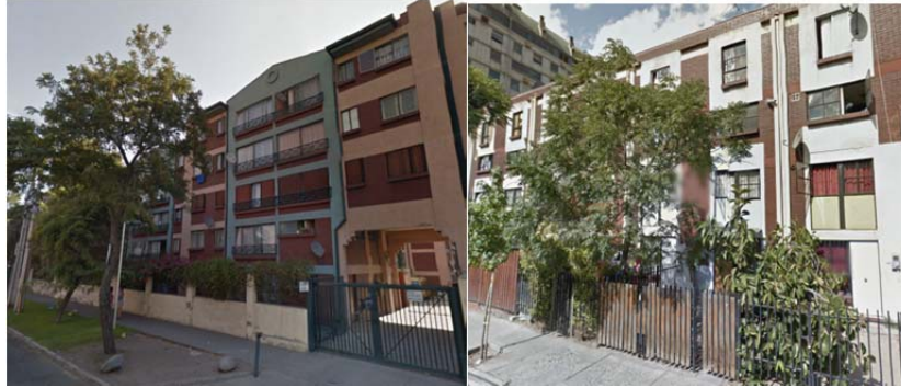
Figura 5: Tipología edificación Primera Renovación
