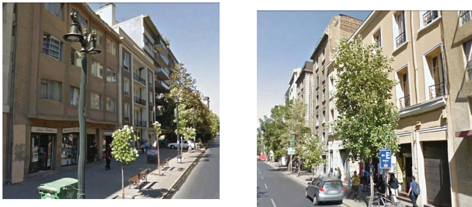
Figura 4: Tipología Edificaciones Antiguas
